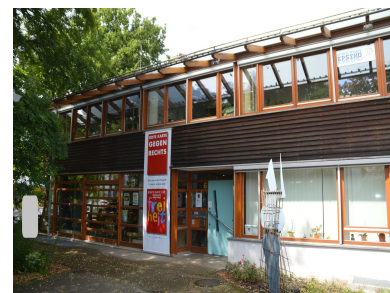
Bremen, Bürogebäude, 575 TEU
