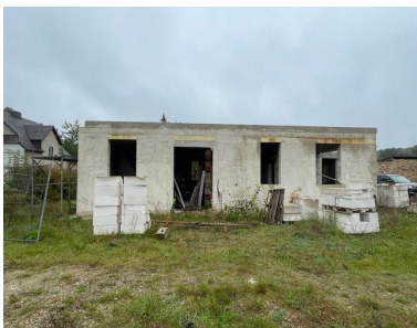
Bad Muskau, Rohbau, 62,5 TEU
