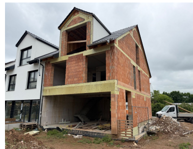
Offenbach/M, Rohbau EFH
