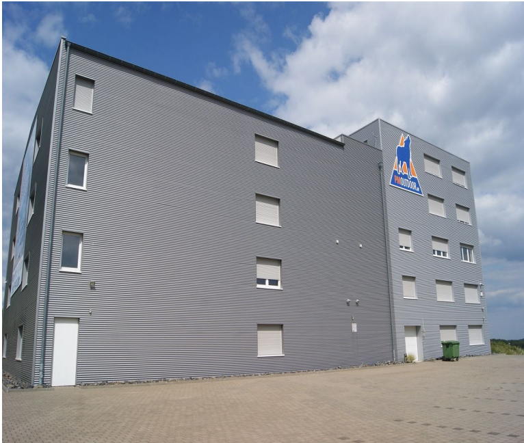
Büro- und Lagergebäude, Siegerland-Flughafen Burbach, 2 Mio EUR
