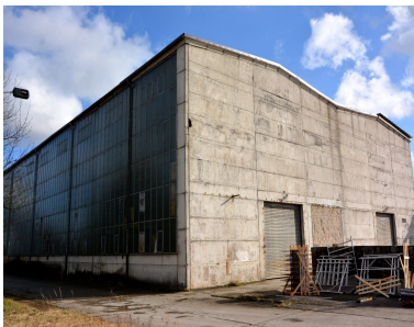
Betonwerk, Barth, 1,14 Mio EUR
