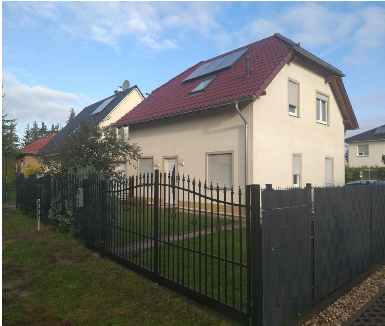
Einfamilienhaus in Falkensee, 559 TEUR
