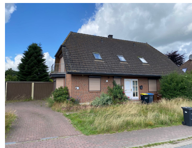
Thaden (SH), Zweifamilienhaus
