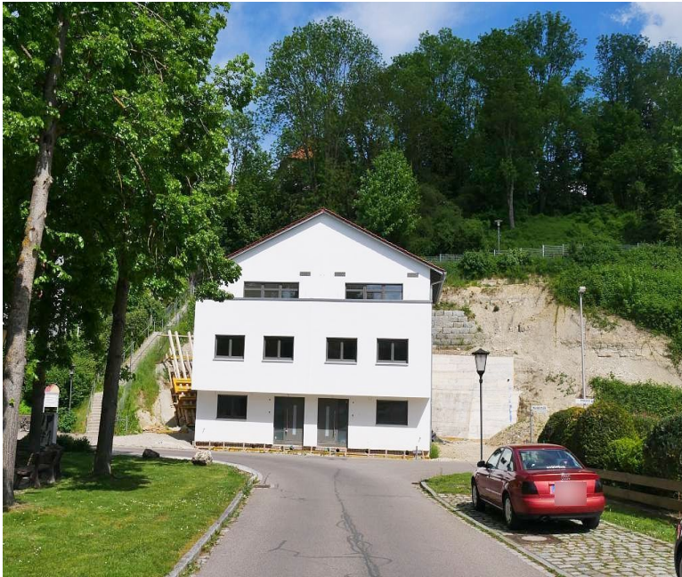
Oberkirchberg, Doppelhaus im Bau
