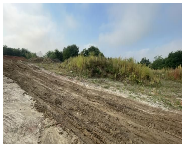
Frankfurt/ O., Baugrundstück
